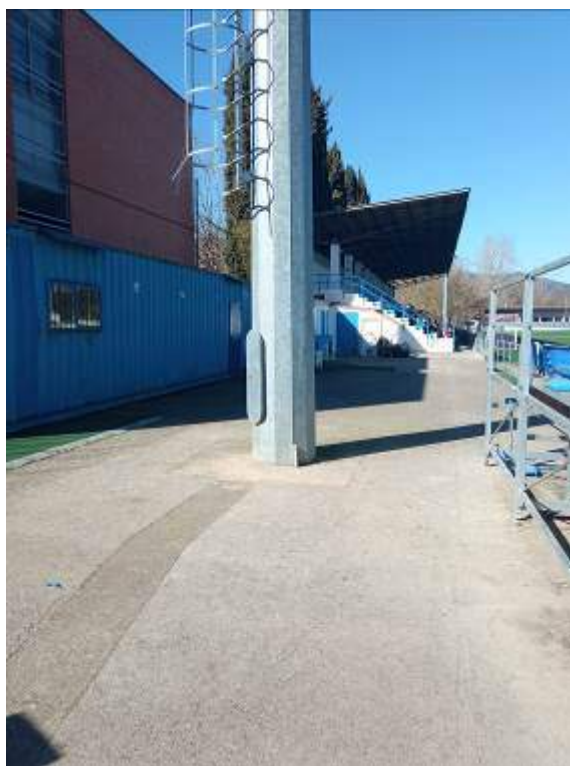
Fig.02 Detalle de la base de la Torre SE
